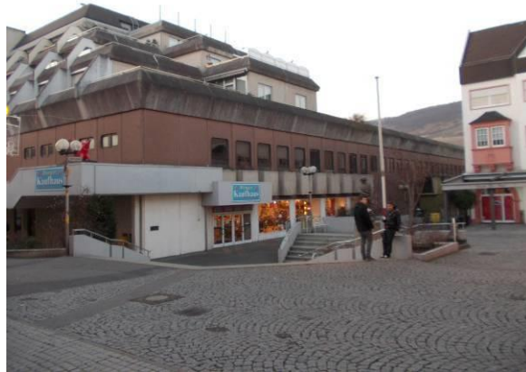
Platz mit Treppenanlage vor dem ehemaligen Hertie-Gebäude
