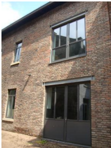
Hofsituation Untere St. Nikolausgasse
