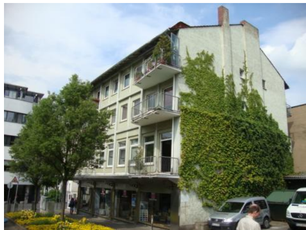
begrünte Brandwand Kapuziner Straße
