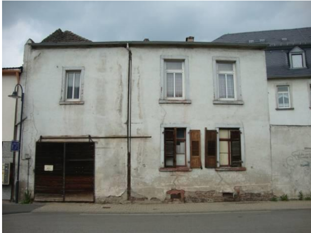
Gebäude mit schweren Mängeln und Leerstand
