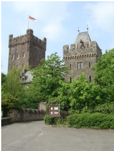
Haupteingang zur Burg Klopp
