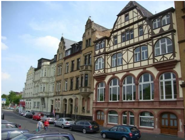
östliche Bauzeile Rheinkai
