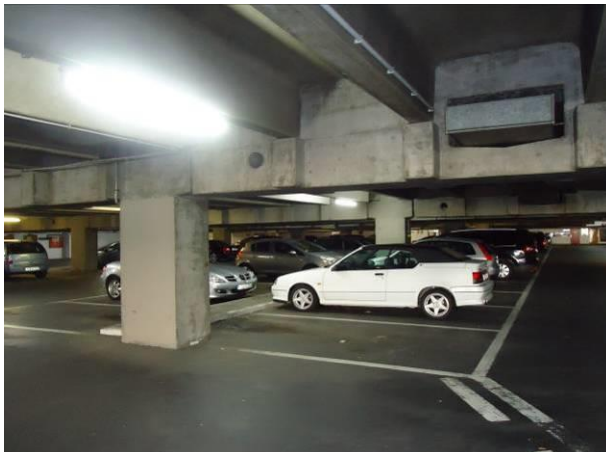
Parkraumpotenzial im ehemaligen Hertie-Gebäude
