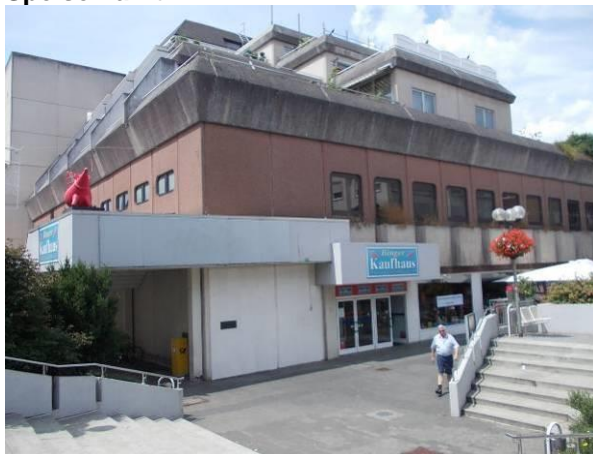
Ansicht Basilikastraße 3, ehemaliges Hertie-Gebäude
